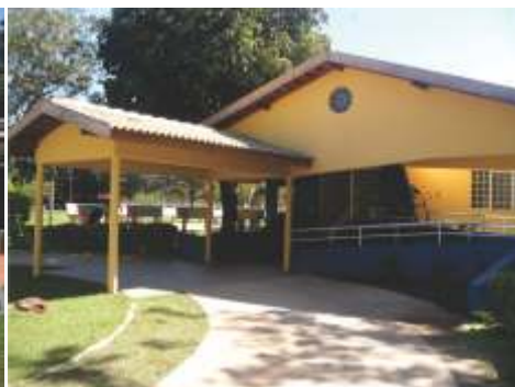
Rampa de acesso ao salão de festas
